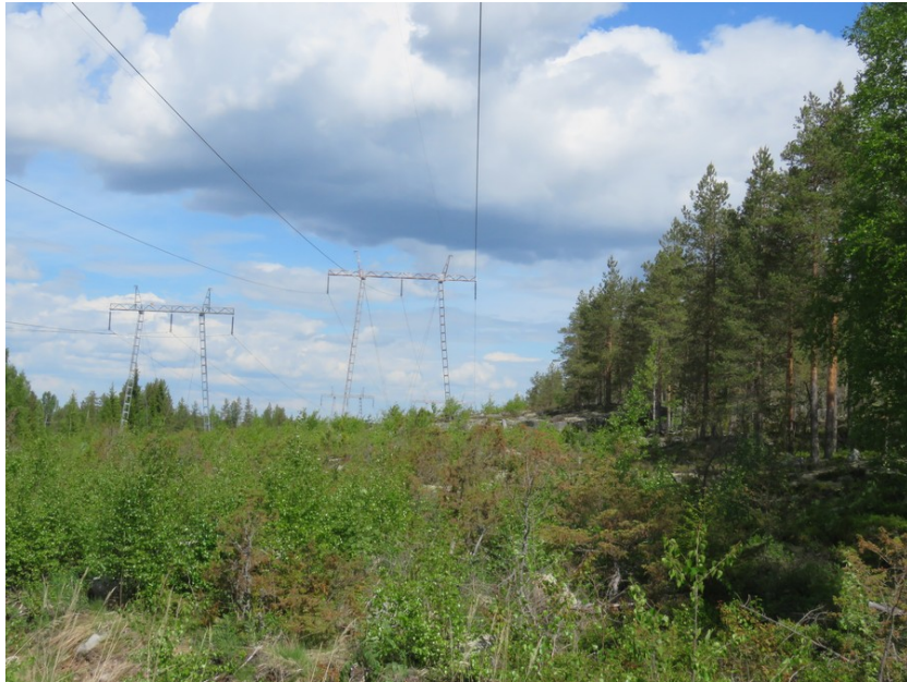
Kuva 3. Liittymiskohta 110 kV voimalinjalle. Metsätien eteläpuolella on laajempi hieman kohoava kallioalue.
